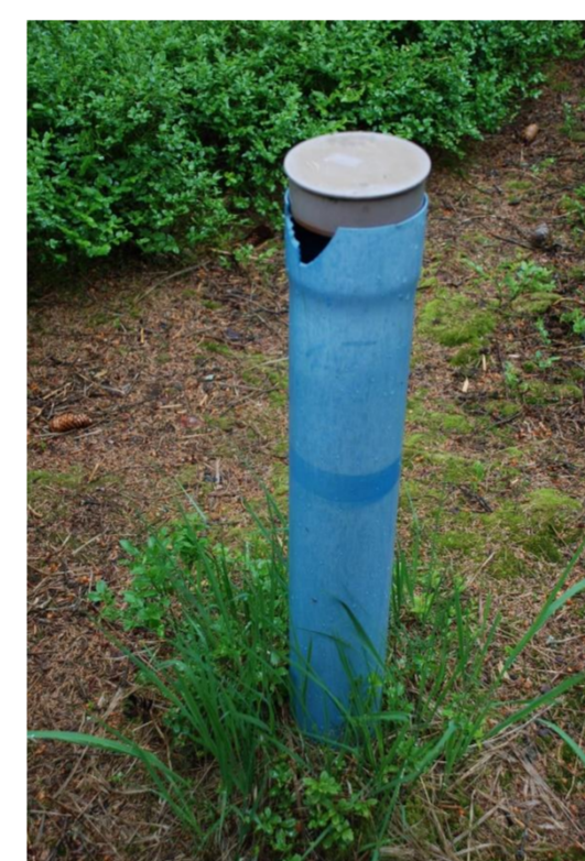
Abb. 2: Moorpegel: PVC-Rohr DN115, Länge ~2m, Verfilterung unterflur
