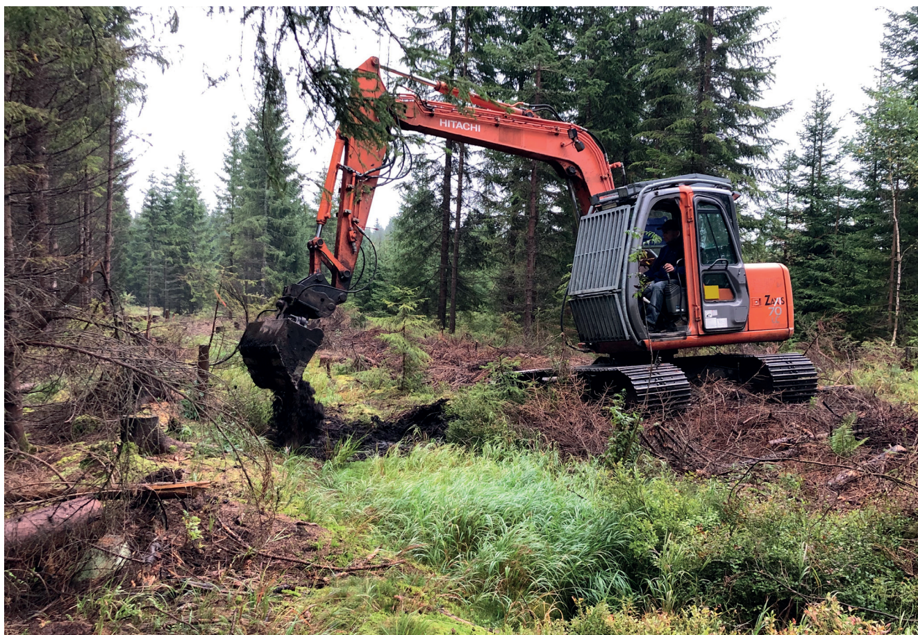
Abbildung 18: Bagger beim Setzen eines Staus mit Torf (Foto: Isabelle Fanghänel)
