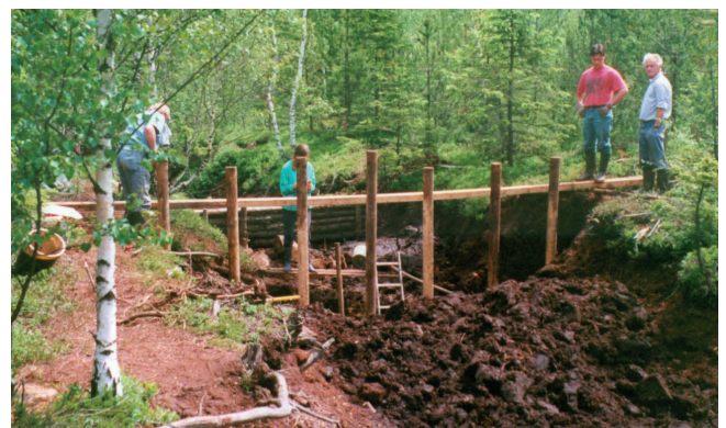
Abbildung 8: Bau eines Rundholzdammes in der Hühnerhaide im Jahr 2002 (Foto: Anke Haupt)
