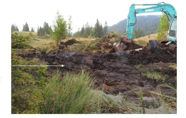
Beidseitiges Verfüllen der Spundwand mit Torf
