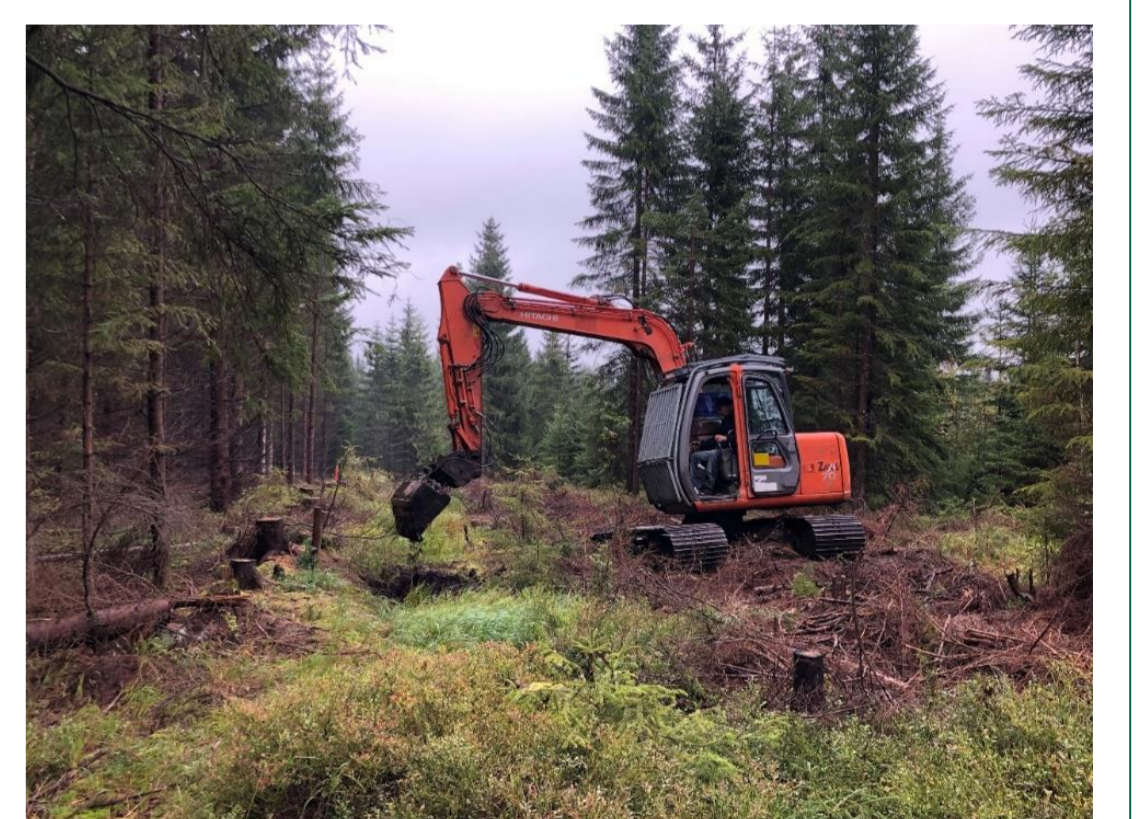
Angepasste Baggertechnik setzt Stau aus umliegendem Torfmaterial im Heuschuppenmoor bei Johanngeorgenstadt (Foto: I. Fanghanel).
